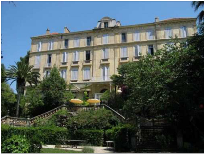
Vue plein sud
