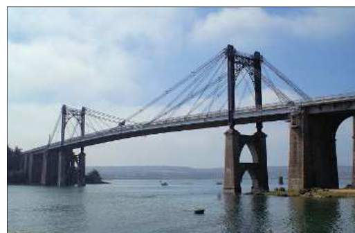
Le pont suspendu de Lézardrieux
