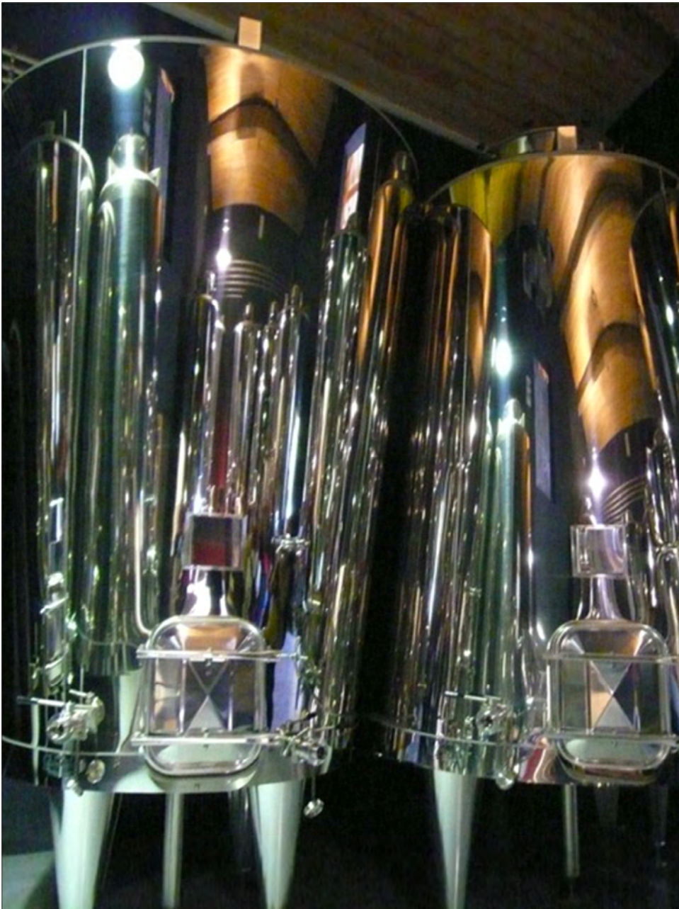
Les nouvelles cuves des chais du Château Fonréaud de Listrac-Médoc
