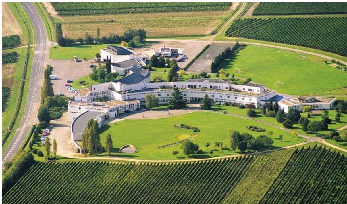
Vue aérienne du lycée Edgar Pisani
